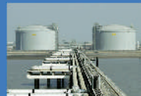
LNG Terminal Project Petronet LNG Ltd.
